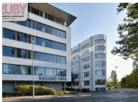
Praha 3 | U Nákladového nádraží
