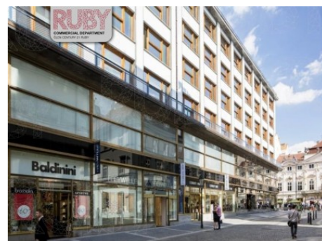
Praha 1 | Na Příkopě
